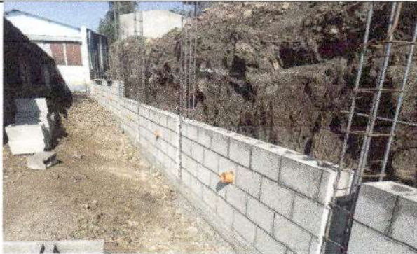
Foto 3: Reparación de muro perimetral.
