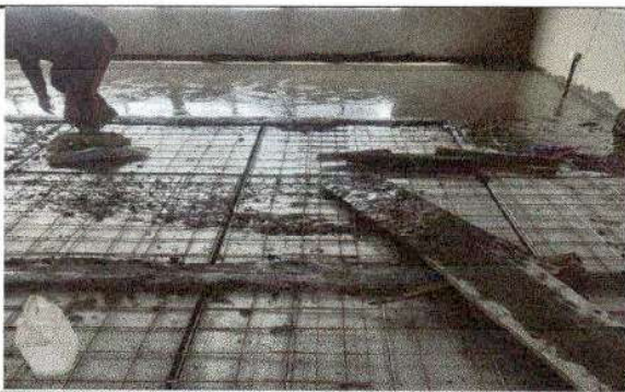
Foto 5: Fundición del piso de granito.
