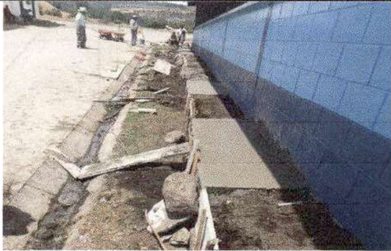
Foto 1: Reparación de banqueta de concreto.
