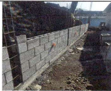
Foto 4: Reparación del muro perimetral del lado norte.
